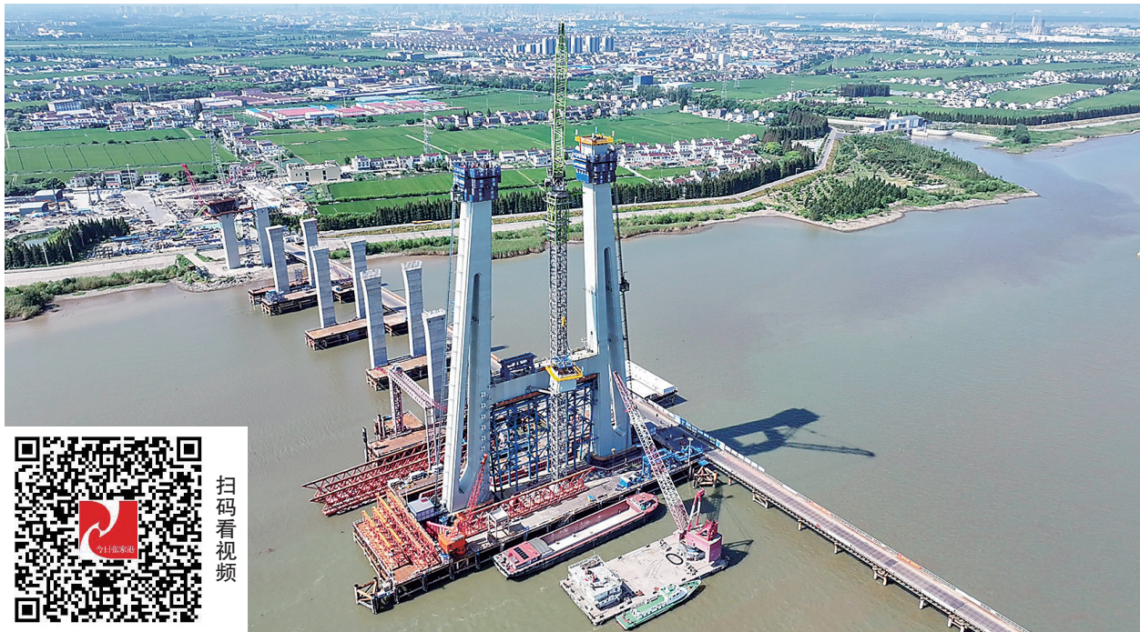
张靖皋长江大桥首个索塔塔柱施工完成 任广真 陶啸天 摄
