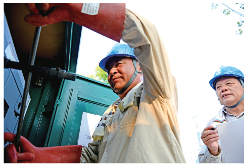
7月31日,区供电公司配电运检部员工周连根(左)在工农路1号环网柜进行负荷转换操作。连日来,该公司配电运检部员工冲锋高温抢修恢复电最前线,为辖区内的用户送去安全可靠的电源。唐建军 沈泉摄
