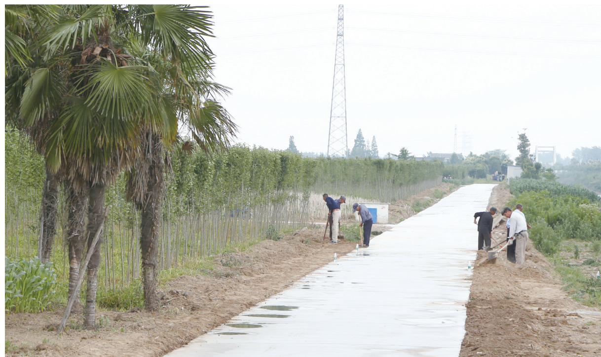
近日,大丰镇丰裕居委会四组在实施中心路绿化工程。据悉,该道路全长550米,水泥路面宽3.5米,两侧路肩各宽1米,预计7月中旬交付使用,将大大方便该村北三排农庄村民生产生活,提升乡村交通环境。王越 摄
