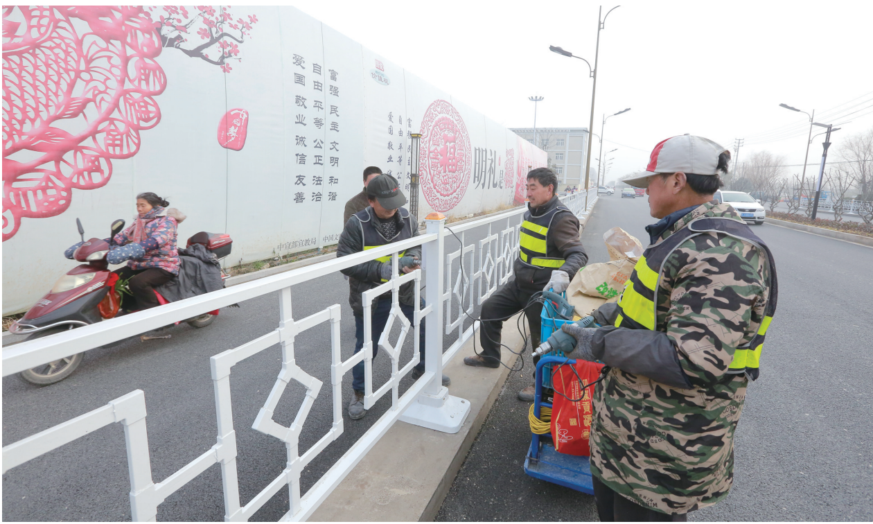
1月24日,工人们正给沈方路护栏安装护栏灯。沈方路大中镇路段是通往城区的主要交通道路,具有车流量大、车种多等特点,安装护栏LED灯有利于保障市民夜间行车安全。 胡金波 摄
