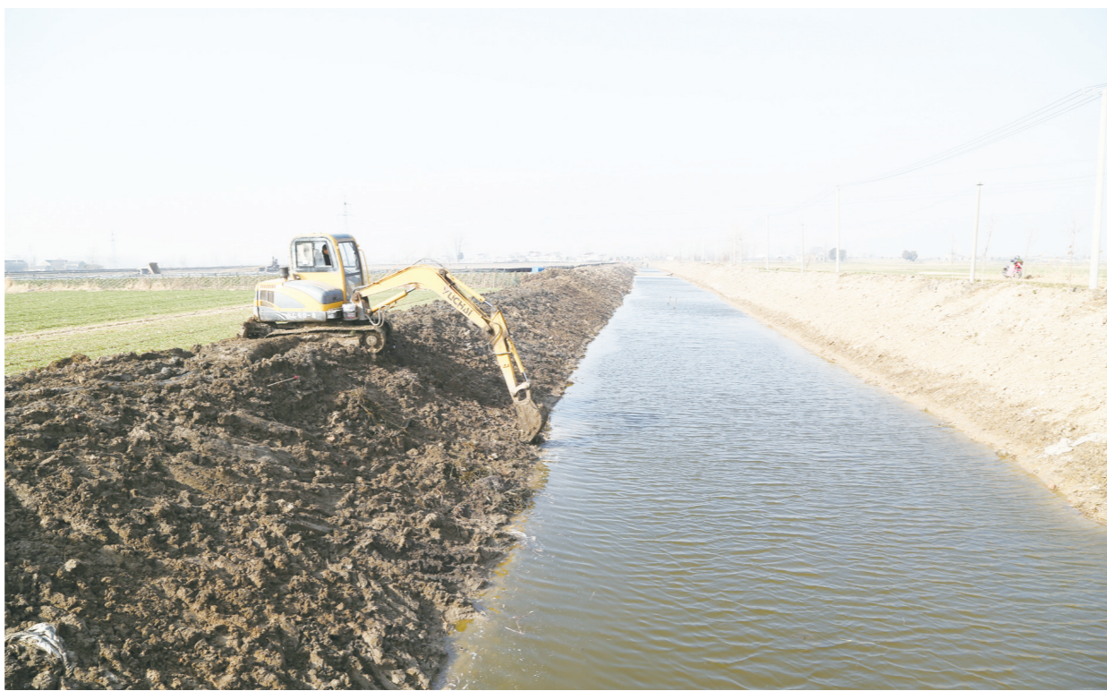
2月23日,小海镇新村村河道疏浚工程正在进行。据悉,该村通过多途径投入,对淤积严重的河道全部进行疏浚,计划疏浚中沟8条、小沟11公里、土方23.37万方。 王越 摄
