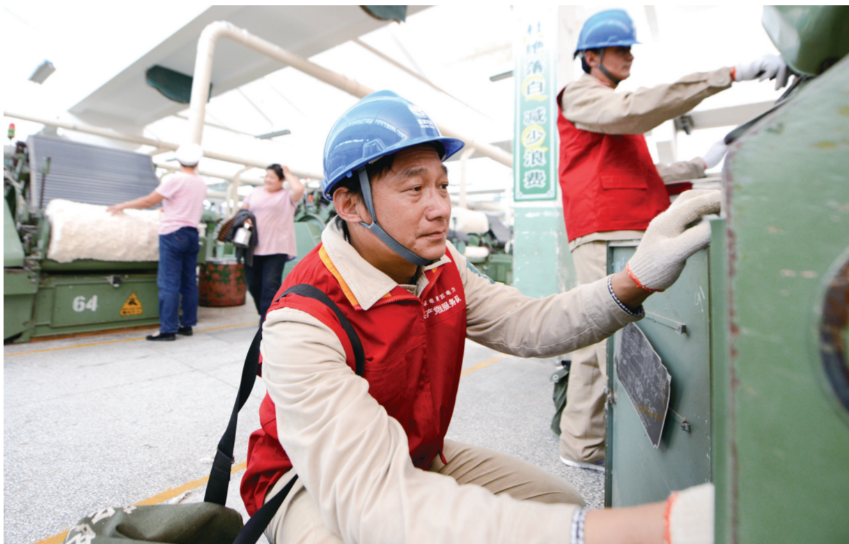
3月24日,大丰供电公司党员服务队队员在庆丰纺织有限公司协助检查供电设备,保证安全生产。连日来,该公司组织15支党员服务队,深入全区150家企业车间对配电设备、安全工器具进行“体检”,排查安全用电隐患,确保企业安全可靠用电。截至目前,5条隐患得到整改,19条安全隐患列入整改计划。唐建军 摄
