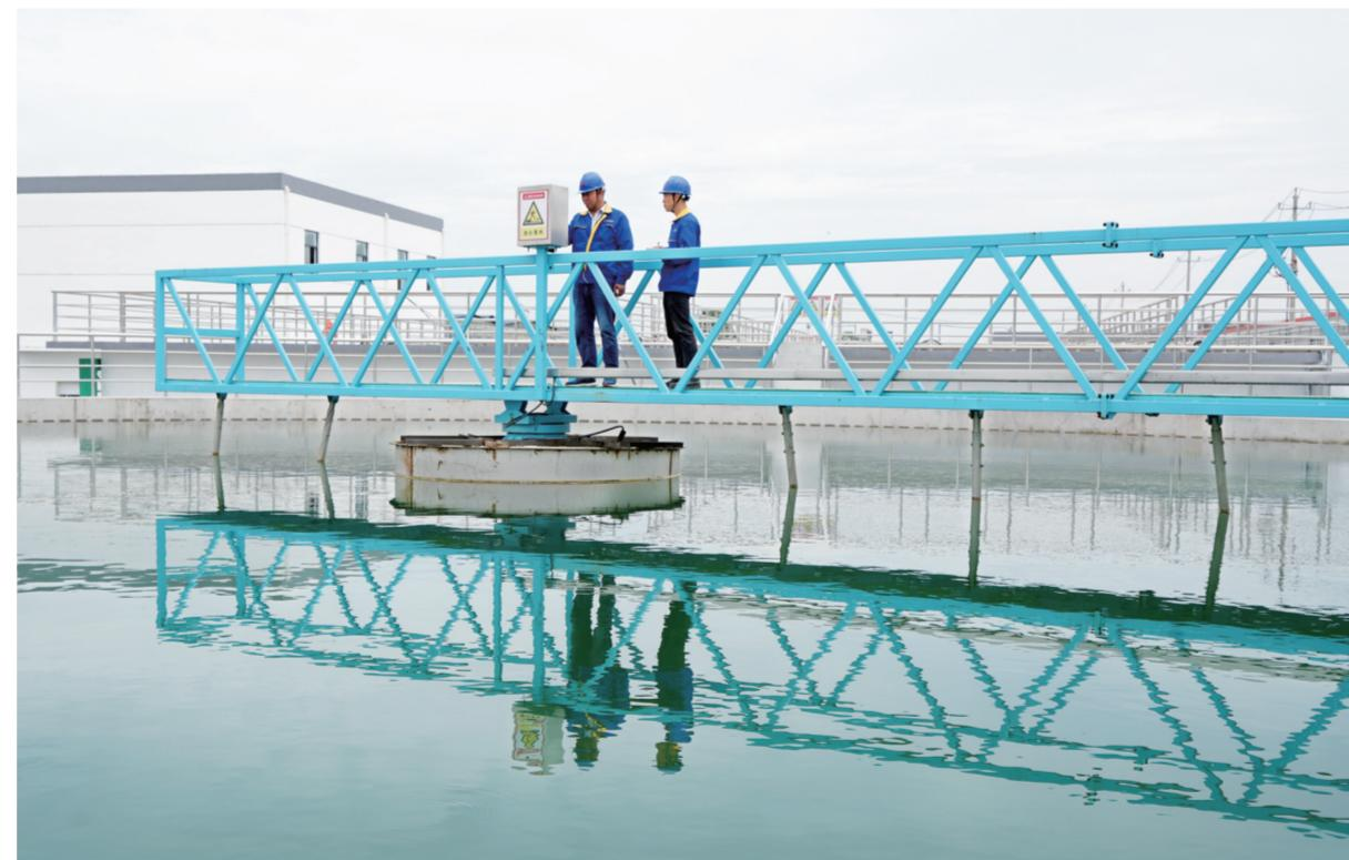
6月1日,小海镇园区污水处理厂的二次沉淀池上,工程师正在调试半桥式刮泥机。据了解,该厂总投资5000多万元,铺设配套管网16.17公里,采用物化+生化的处理工艺。3月底投入试运行以来,已接纳园区内所有纺织企业6千多台织机污水,日处理能力达1.5万多吨,经检测各项指标均基本符合国家规定排放标准,将于本月底正式投入运行。 单培泉 沈丹 报
