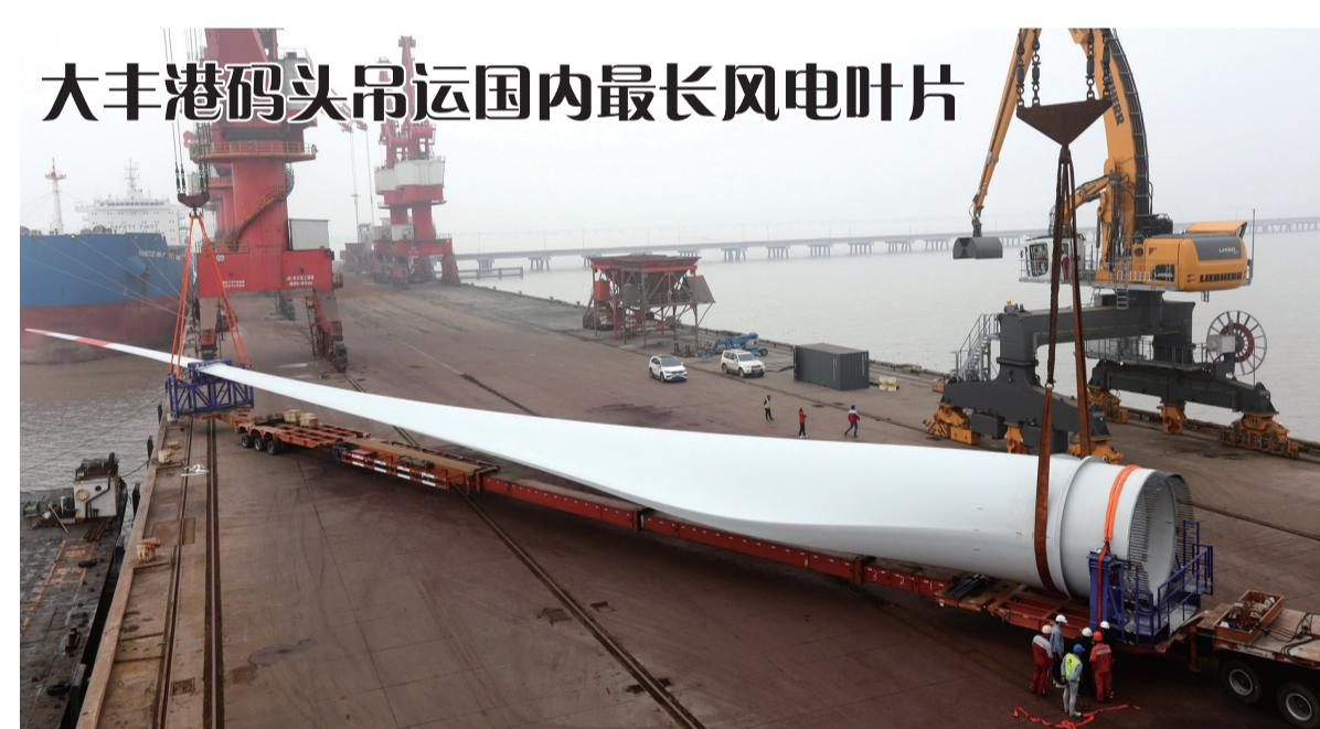
10月11日，在大丰港通用码头，一个长90米的风电叶片正被吊装运往三峡海上风场。该叶片是国内实际投入使用最长的风电叶片，为确保本次叶片的成功出运，码头吊装团队经过数十次的推演和模拟练习，最终创新采用“甩尾吊装”的方式。此次从大丰港成功出运90米的风电叶片，打破了国内港口吊装最长风电叶片的记录，展示了大丰港出色的重大件吊装能力。
