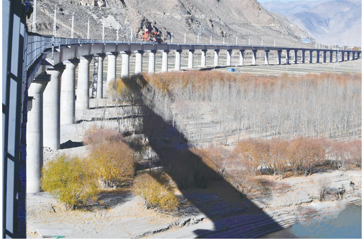
12月1日，中铁十一局铺架队工人正在进行拉林铁路第二次跨越雅鲁藏布江的铺轨。当日，位于西藏山南市桑日县绒乡附近的拉林铁路绒乡雅鲁藏布江特大桥完成铺轨，这是拉林铁路第二次跨越雅鲁藏布江。绒乡雅鲁藏布江特大桥全长4615米。拉林（拉萨至林芝）铁路全长435.48公里，设计时速160公里，是西藏首条电气化铁路，共跨越雅鲁藏布江16次。自2018年10月正式铺架至今，已完成铺轨114公里，预计2020年底完成全线铺架。
