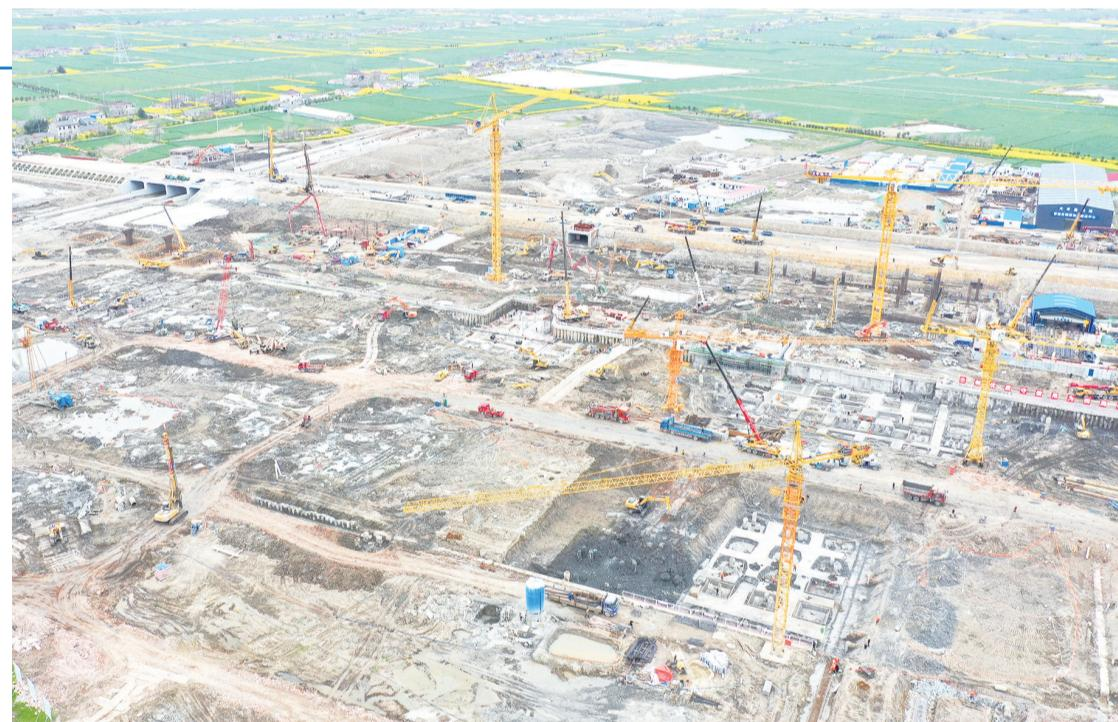
4月7日，记者在盐通高铁大丰站综合枢纽项目建设现场看到，300多名工人在各自岗位上有条不紊地忙碌着，支架搭设、钢筋绑扎、土方开挖、垫层、底板等各工序同时推进。进入3月以来，中铁四局大丰站综合枢纽项目部多措并举，全力做好防疫、复工“两盘棋”，掀起春季大干热潮。截至目前，项目施工已完成所有的工法桩基，进入主体结构施工阶段。据悉，该项目计划将在6月底完成地下停车场、酒店综合楼、换乘中心等主体结构的建设任务。
