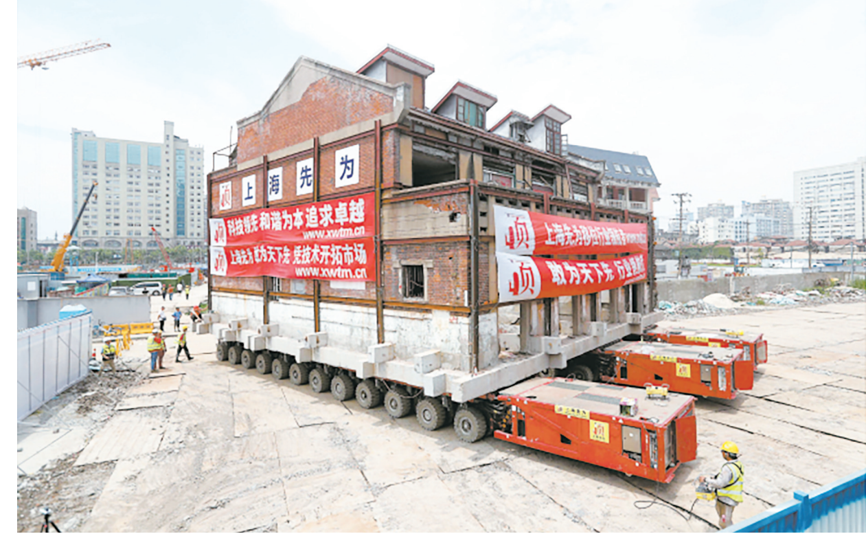
7月12日,位于静安区苏河湾核心区域的安康苑永庆里5幢历史建筑整体平移工程全面启动。5幢建筑同时 整体平移,在上海建筑平移历史上尚属首次;每幢建筑单次平移最远达230米,5幢建筑来回累计平移距离达到 2088米,也创造了上海建筑平移距离之最。
