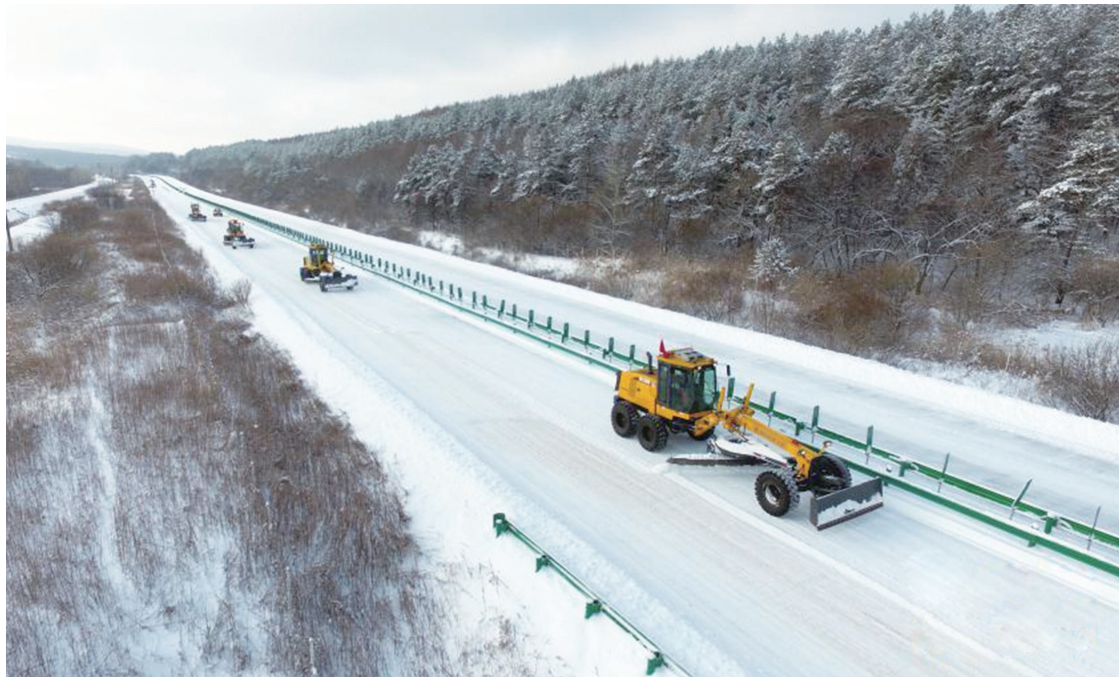
经过当地高速养护部门70多个小时的努力,黑龙江省牡丹江市辖区内的G11、G10两条高速公路近500公里路段的清雪工作21日全部完成,恢复通行。11月18日以来,受降雪天气影响,牡丹江市多条高速公路因冰雪覆盖一度封闭。图为11月21日,在G11高速公路牡丹江市宁安段,清雪车辆进行恢复通车前的收尾作业(无人机照片)。 新华
