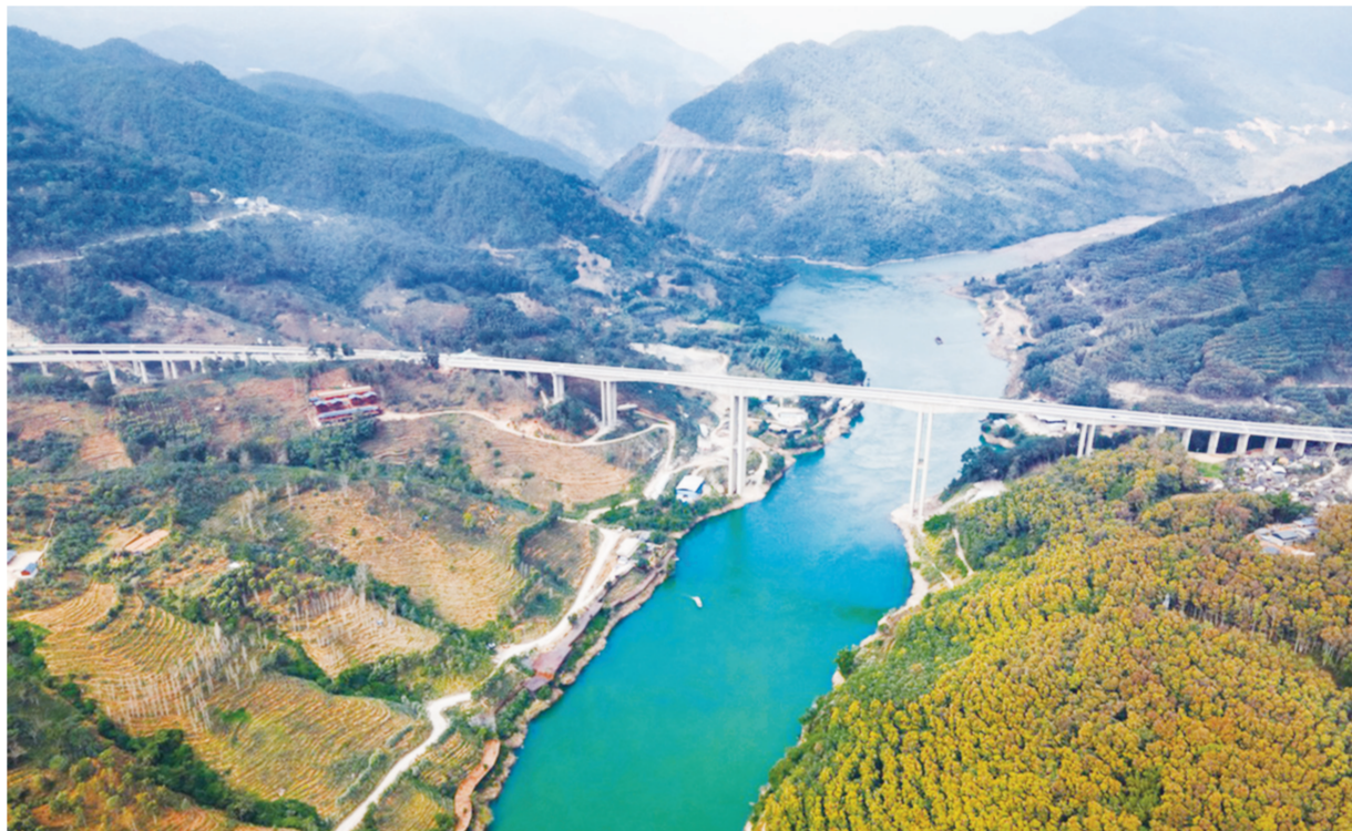
经过5年多的建设,云南省墨江县至临沧市高速公路1月13日建成试通车。记者从云南省交通运输厅了解到,该条高速公路通车标志着全省16个州市全部通高速公路。图为墨临高速公路澜沧江(昔归)特大桥。 人民
