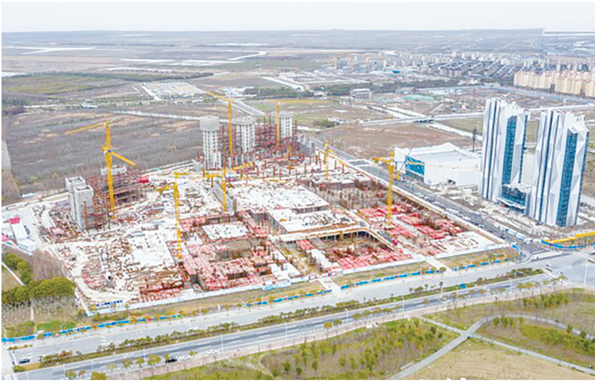
近日,位于上海市临港新城杞青路与沪城环路交叉口的全球最大室内滑雪场项目“冰雪之星”施工现场,一派忙碌景象,多台吊机来回穿梭,工人们在对滑雪场地下室结构顶板和酒店钢结构施工作业。 上观
