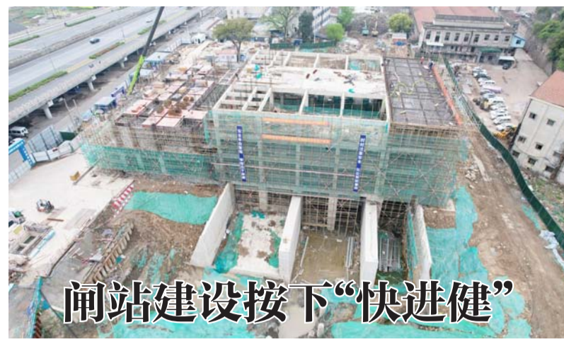
位于余英溪至东苕溪入口处的新民桥闸站工程建设正如火如荼。新民桥闸站工程是省重点工程——苕溪清水入湖河道整治后续项目(德清县段)的重要组成部分,总投资约1亿元。该项目的建设将极大提升德清城区的防洪排涝能力,为区域防洪安全提供有力保障,同时改善水生态环境。 记者 王家浩
