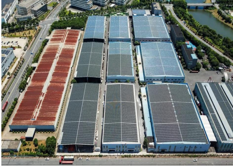
德清县供电公司武康供电所副所长潘启明介绍，此次投运的康盟光伏电站总装机容量达4.744兆瓦，覆盖屋顶面积28000平方米，采用了电量全额上网方式，并网后，年
