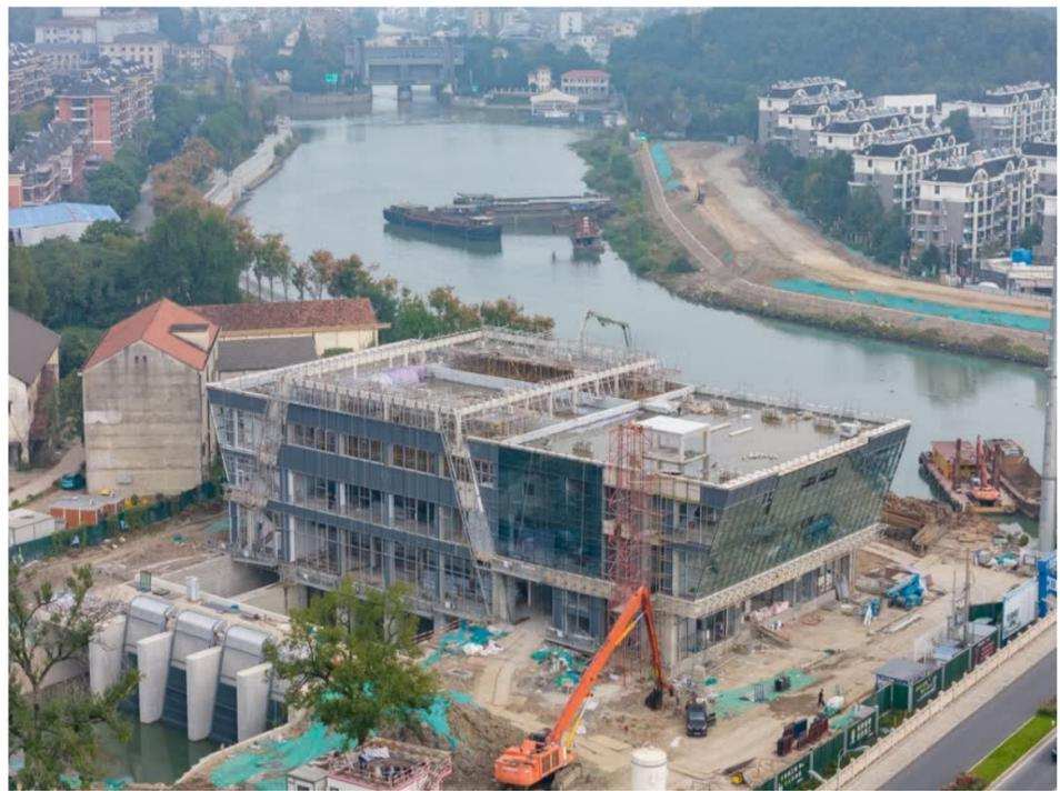
正在进行室内装修和室外玻璃幕墙安装,预计在12月底全部完成,比原计划工期提前两个月左右。
