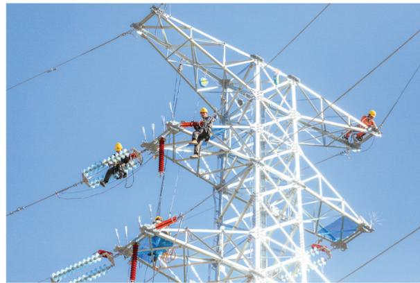
近日,洛舍镇砂村村,国网德清县供电公司工作人员正在进行110千伏钮洛线迁改工作,服务当地“源文化”项目建设。110千伏钮洛线为220千伏钮家变电站至110千伏洛舍变电站供电线路,线路迁改后,可减少线路长度5.7公里,进一步提高土地资源利用率。
