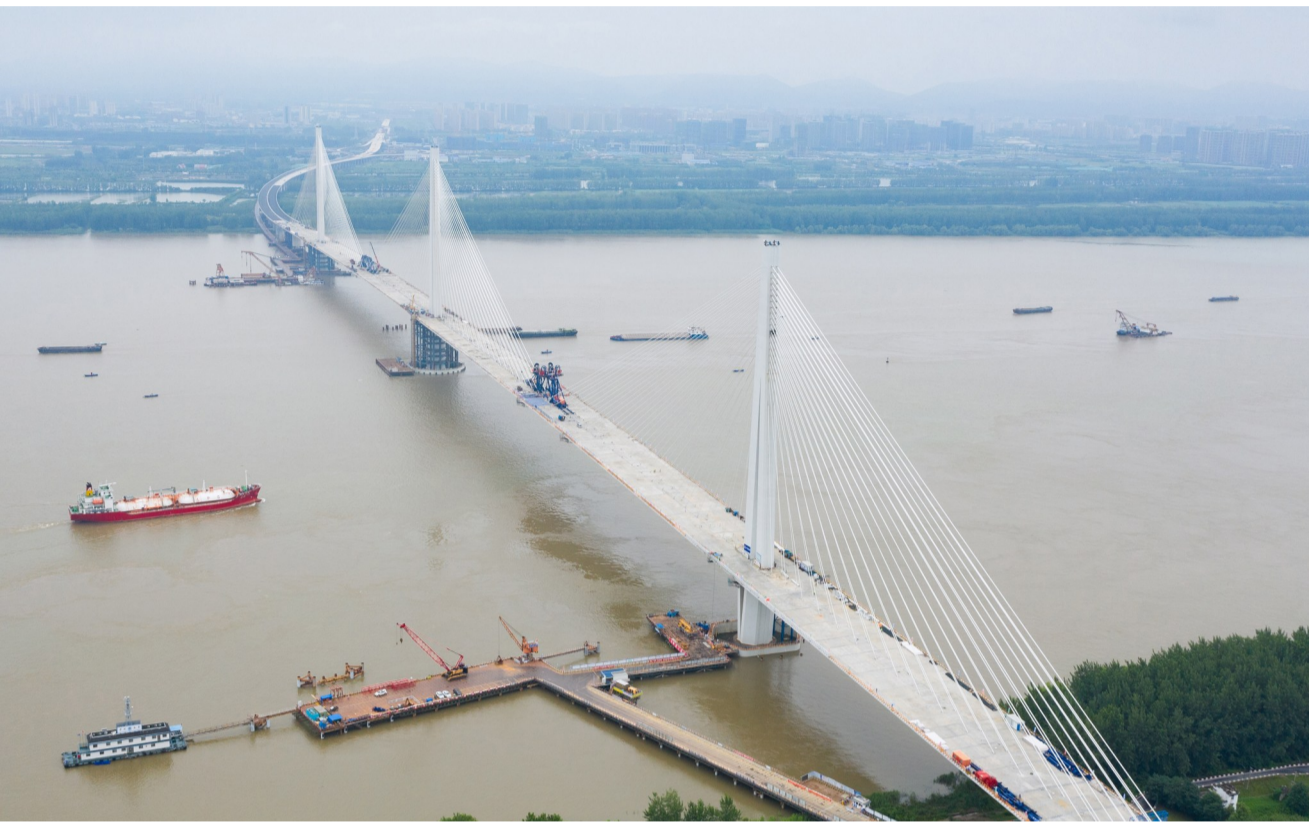
这是6月28日拍摄的南京长江第五大桥(无人机照片)。当日，南京长江第五大桥顺利合龙。南京长江第五大桥是连接南京江南主城区和江北新主城区的重要纽带，兼具干线公路和城市快速路功能。
