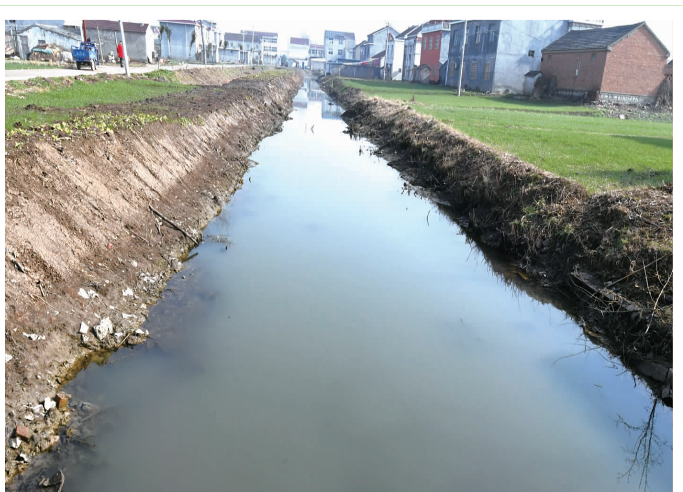
今年以来,张店镇以镇区为点、镇域为面、主要干道为线开展黑臭水体治理工作。目前共整治黑臭水体8条,总长2880米。图为已整治完成的河塘。(尤子龙 马丽媛 摄)
