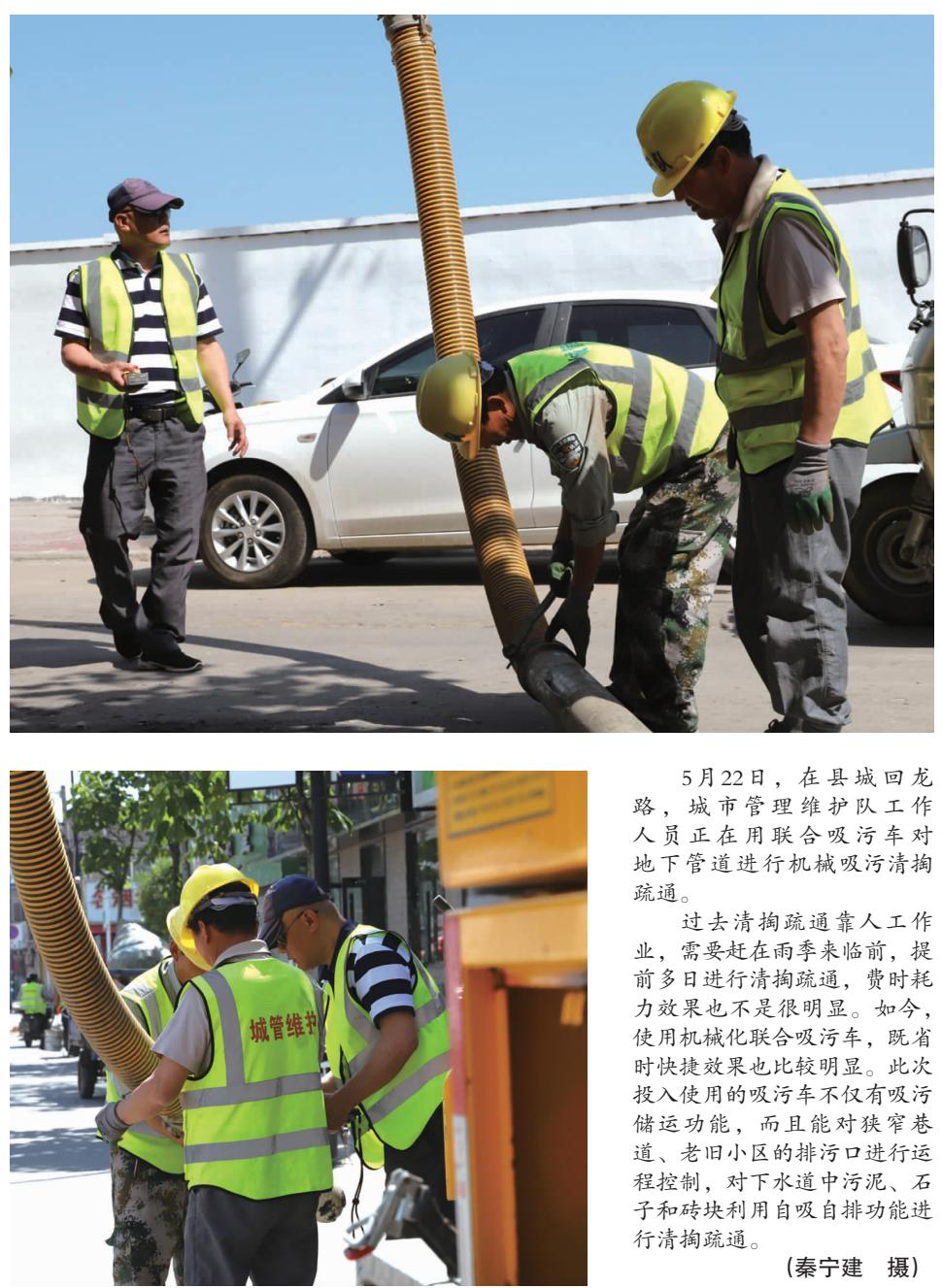
5月22日,在县城回龙路,城市管理维护队工作人员正在用联合吸污车对地下管道进行机械吸污清掏疏通。
