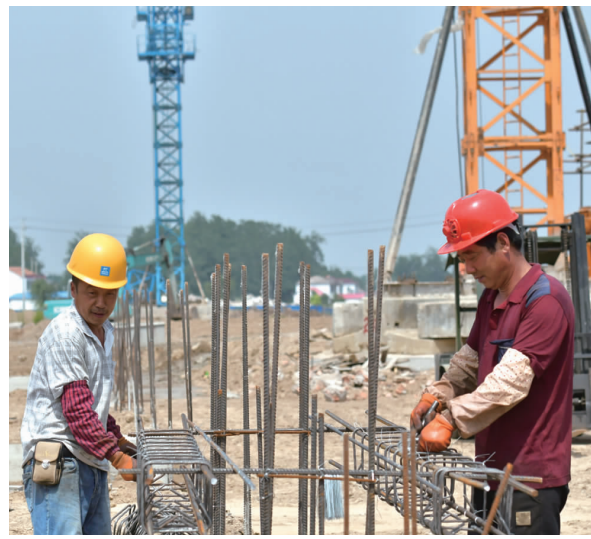
近日，记者在新集镇徐老庄新型农村社区建设现场看到，工人们正利用当前晴好天气，加紧建设。目前，160平90套已全部开挖，200平54套，整层全部结束，180平前60套开挖结束，基础垫层混凝土完成。 该项目涉及整个徐老庄村和菊花村、大元村、唐庄村局部农民居住点，计划拆迁合并自然村组9个，计划农民集中安置小区规模257亩，可安置农户520余户。预计2020年底前竣工。图为施工现场。(尤子龙 摄)
