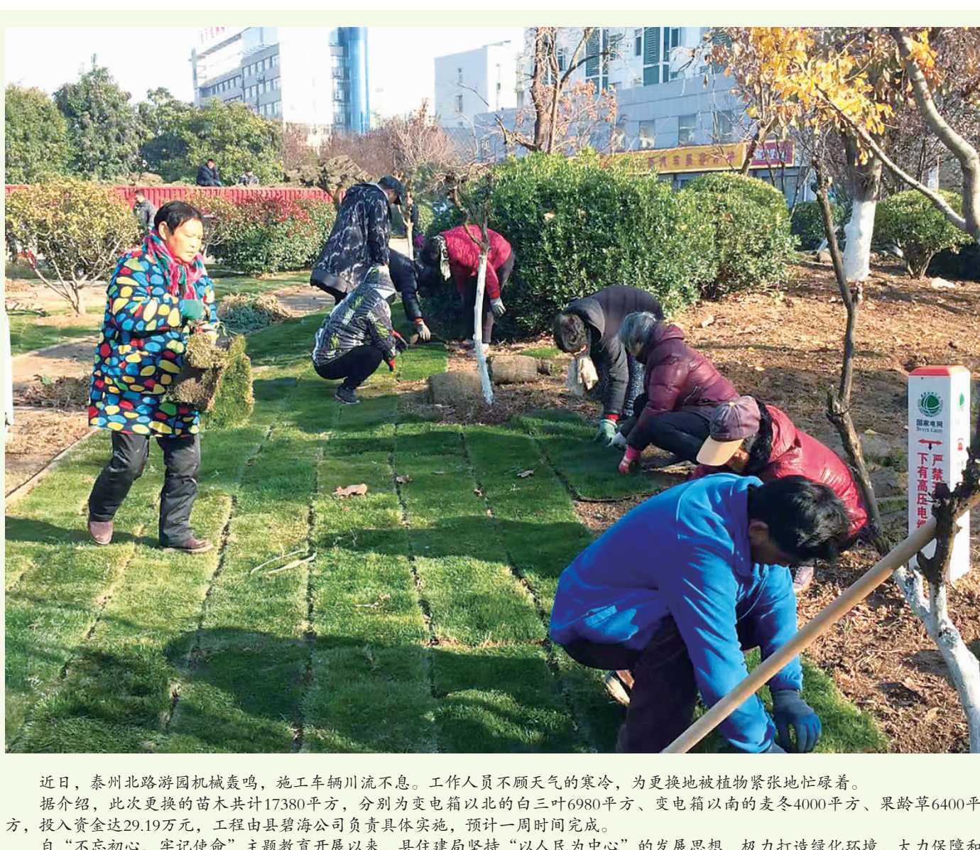
近日，泰州北路游园机械轰鸣，施工车辆川流不息。工作人员不顾天气的寒冷，为更换地被植物紧张地忙碌着。据介绍，此次更换的苗木共计17380平方，分别为变电箱以北的白三叶6980平方、变电箱以南的麦冬4000平方、果岭草6400平方，投入资金达29.19万元，工程由县碧海公司负责具体实施，预计一周时间完成。
