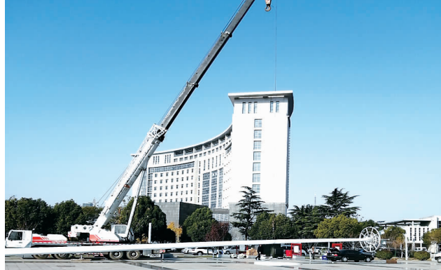
为不断提升市政设施维修管护水平，加强广场公园管理，12月6日，县综合行政执法局广场公园管理处通过前期摸底排查准备，组织人员对市民广场的破损灯杆拆除并及时更换新灯具，确保夜间照明效果，提升亮化水平，给广大市民提供一个整洁、明亮的娱乐活动场所。(尤子龙 夏正波 摄)
