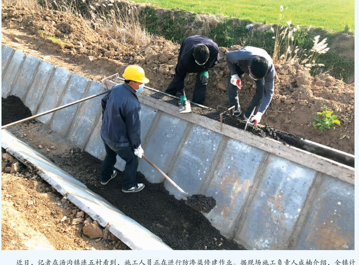
近日，记者在汤沟镇连五村看到，施工人员正在进行防渗渠修建作业。据现场施工负责人成楠介绍，全镇计划修建水渠14700米，农路15200米，电灌站8座，农桥13座。项目建成后将有效提高现有粮田的产出效率，提升粮食综合生产能力。
