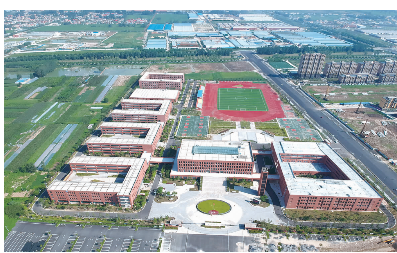
灌南县实验中学新校区于2014年开始建设。实验中学新校区按照全省一流的现代化中学的标准进行规划设计, 它位于新港大道(北环路)南侧、新莞北路西侧、惠泽路北侧, 总占地面积约158亩, 建筑面积约7.3万平方米, 包括行政楼、教学楼、宿舍楼、实验楼、餐厅等设施。总投资1.75亿元, 设计办学规模为80个班级, 可容纳4000名学生就读、2000名学生寄宿。
