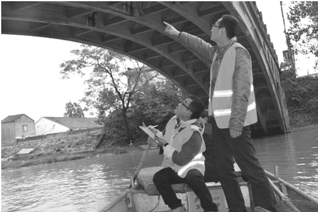
近日,区公路站组织专业技术人员对全区范围内的141座二类农村公路桥梁的安全质量逐一诊断,重点检查桥墩基础、桥梁结构、桥面护栏等附属设施是否完好,安全是否达标,以确保农村公路桥梁安全过冬。图为技术人员在石塘桥检查。 建堂 学军 要霖 摄
