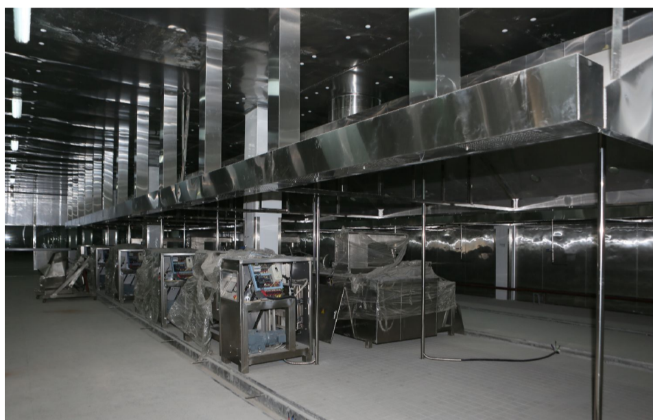
由淮安苏食肉品有限公司投资2亿元兴建的苏食食品加工物流中心二期工程主体工程,项目设备已经安装,即将投产。 李峰摄
