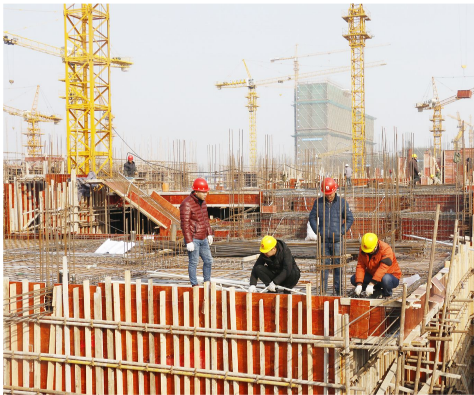
御锦城三期御景星城项目由淮安市天润房地产开发有限公司承建,位于楚州大道西侧、山阳大道北侧,总建筑面积超过22万平方米。该项目去年10月份开工,预计2019年1月份交付使用。图为建筑工人正在冒严寒加快施工。 章士涛 韩峰摄
