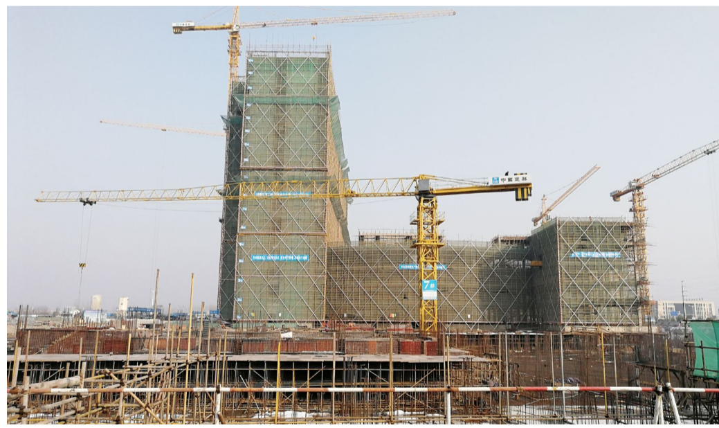
计划投资10亿元的淮安医院迁址新建项目,目前新医院主楼封顶,施工单位正在加快建设进度,确保在2019年5月前竣工交付使用。 严曼曼 摄
