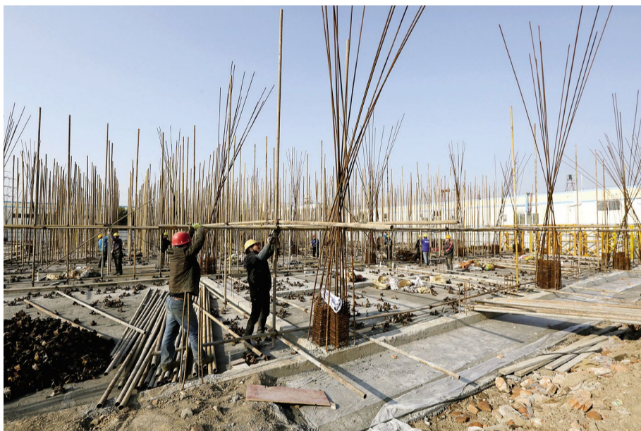
永安制药一期项目去年实现开票销售近4000万元。正在建设中的二期项目正月初六已全部复工,近百名工人抢抓工期,加班加点施工。预计4月上旬7000多平方米的厂房封顶。 李峰 摄
