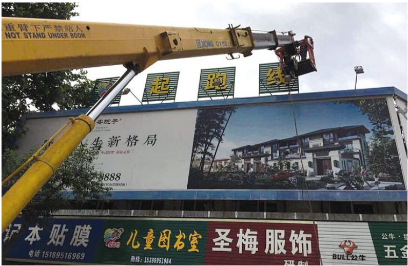
近日,区城管局组织人员对镇淮楼东西路沿街违规户外广告招牌进行集中整治。截至6月30日,该局拆除镇淮楼东西路违规户外招牌36处,其中拆除广告牌6块,显示屏9个,立牌招牌12块,镂空字9个。
