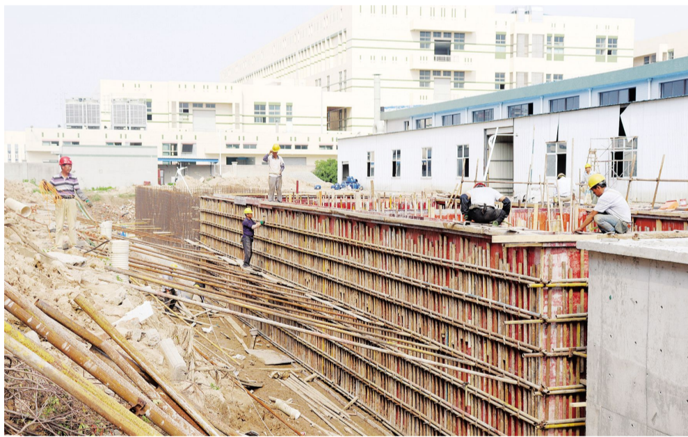
AG防眩光玻璃项目总投资10亿元,占地100亩,新建厂房、办公楼、宿舍楼等建筑面积6万平方米,新上10条防眩光玻璃生产线、8条全自动磨砂后盖生产线以及其它配套设备。项目今年3月开工,预计12月一期建成投产。项目竣工后预计年产车胎防眩光玻璃10万平方米,磨砂手机后盖500万片,年可实现开票销售5亿元以上、税收2000万元以上。图为项目排污系统建设现场。 胡子妍 尹晓晓 摄
