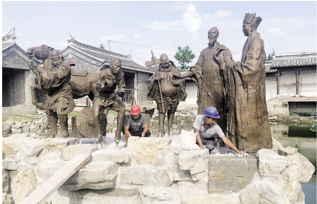
8月7日,工人在吴承恩故居广场工程的吴承恩及孙悟空等群雕前施工。该工程于去年12月开工,目前已完成板跳河黑臭水体整治、城河街至故居广场的石板路铺设、游客中心及徐培艺术美术馆主体框架,正在推进水系景观及广场建设。 王丹 方向东 摄
