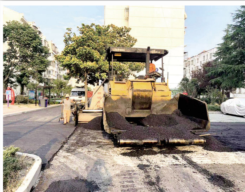
8月22日,由区住建局牵头、市政公用公司实施的淮城街道新城小区内部道路沥青铺设工程经过工人 40 多小时奋战,保质保量完成了铺设任务,得到了业主和群众的一致好评。该工程总投入 52 万元,铺设沥青路面 7000 平方米。 沈海洋 张洋 杨熙旺 摄
