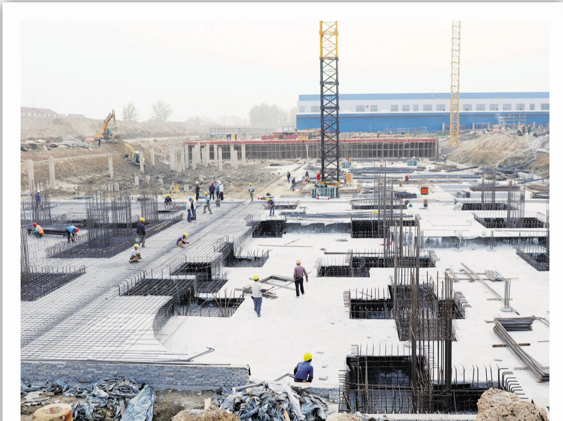
由区农业农村局引进的全稳饲料生产项目生产区厂房钢结构完成总工程量的75%左右，大筒仓、小筒仓土建工程完成，目前正在进行行政区地下工程基础浇筑。 严曼曼 摄
