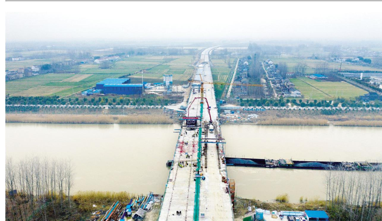
12月28日,省重点交通工程348省道淮安区段——关键控制性节点工程“跨京杭运河特大桥”完成主跨最后一段挂篮现浇施工,至此正式打通了京杭运河南北两岸,为工程道路全线贯通奠定了坚实基础。目前大桥正在进行上部结构拱肋及附属结构的安装。
