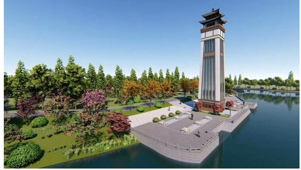
京杭大运河淮安段的灯塔广场项目位于淮安境内,包含塔体结构、广场铺装、环境绿化、夜景亮化等内容。其中,灯塔总高度36米,层高4米,灯塔上部采用仿古亭台建筑样式。广场面积1957平方米,采用石材铺装,设置石灯笼、地雕等景观设施。 张攀江 张迎亮 摄
