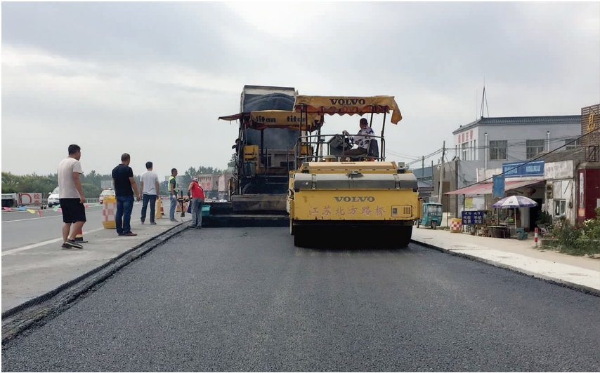
近日，区205国道徐溜治超检查点工程沥青路面摊铺作业正在紧张有序的进行。 ■ 路政
