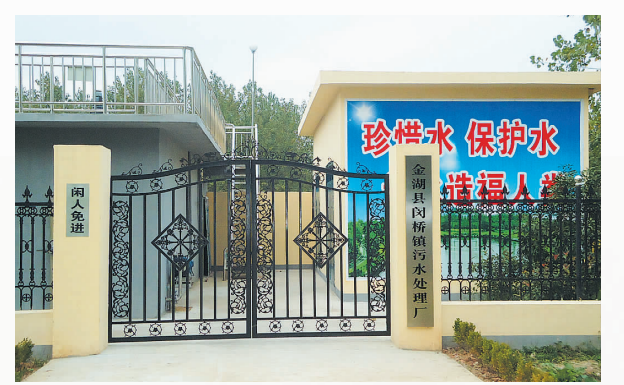
正常运行的污水处理厂
