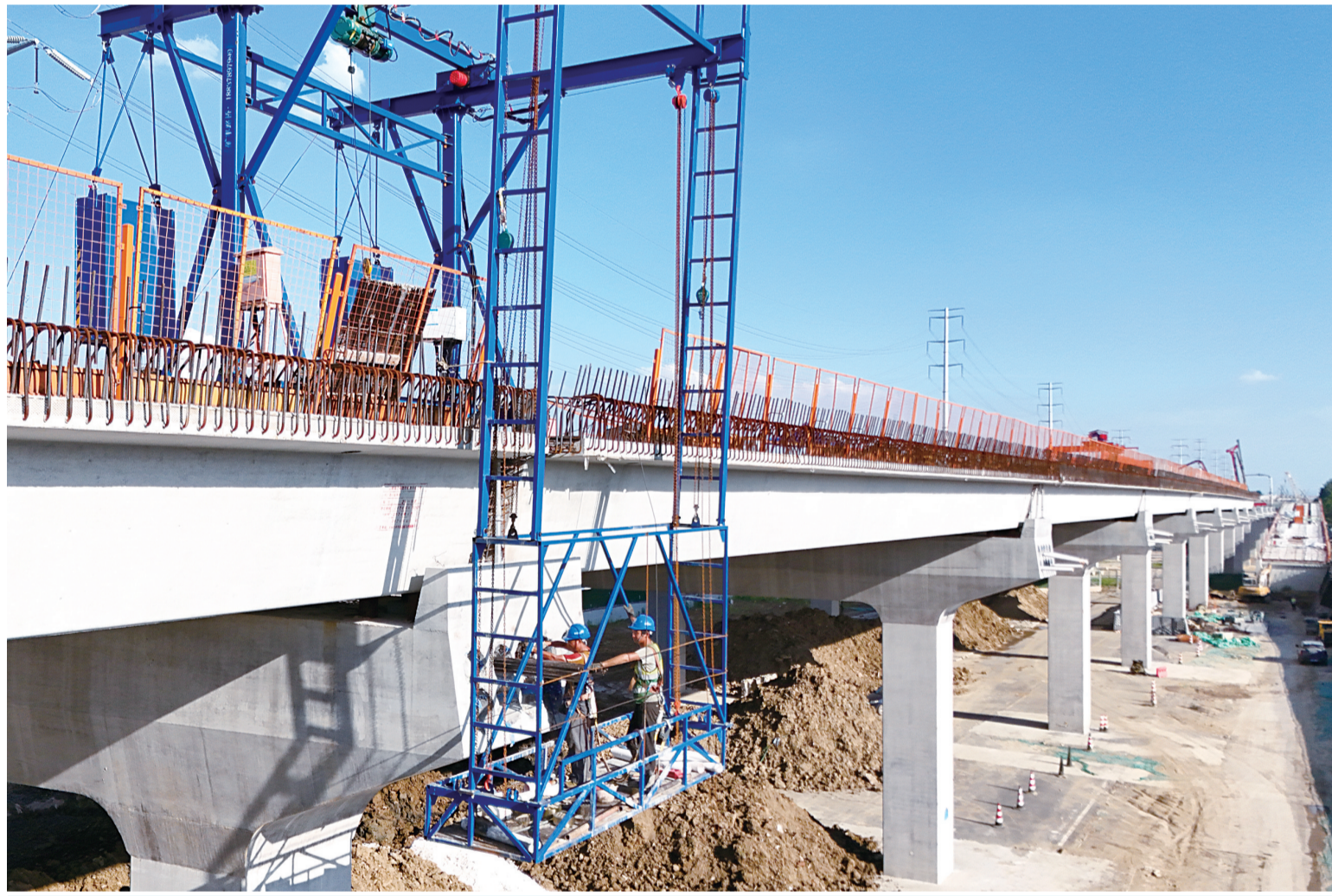
近日,我市遭遇连续高温天气,但重大项目建设同样如火如荼。建设者们不畏酷热、坚守岗位,确保项目建设按计划推进。图为江阴第二过江通道项目建设现场。(丁家骏 摄)
