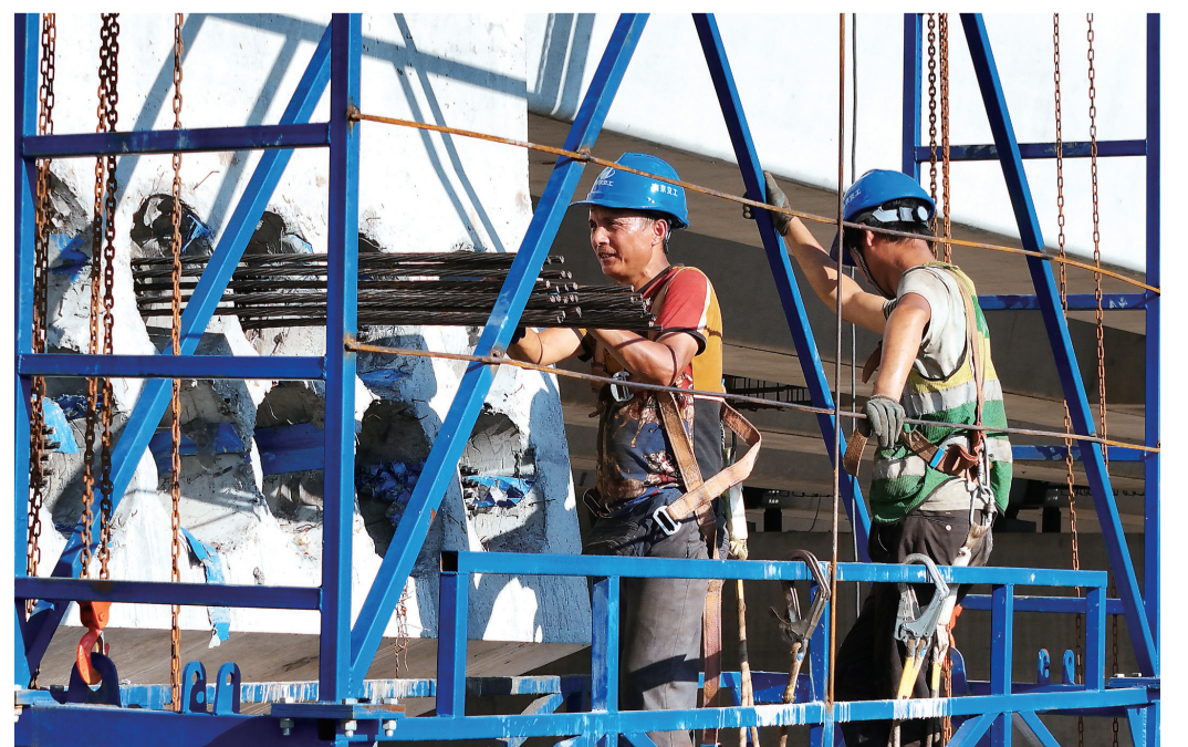
在第二过江通道的施工现场,工作人员正头顶烈日进行作业。
