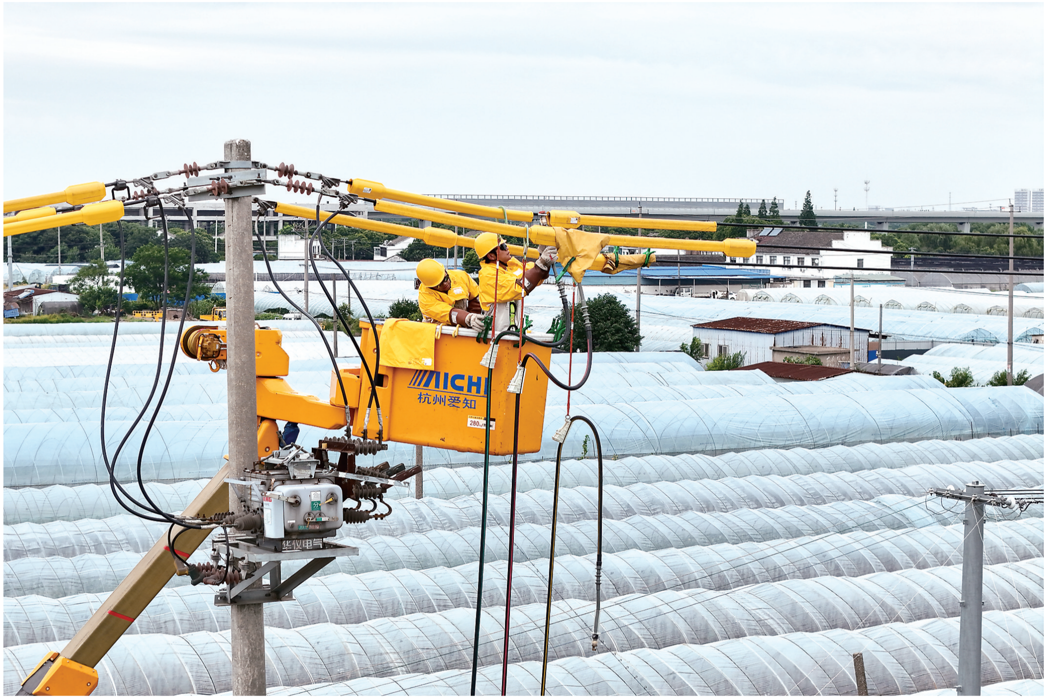
在徐霞客镇10千伏镇西线网架结构优化工程施工现场,施工人员正有条不紊地开展施工作业。
