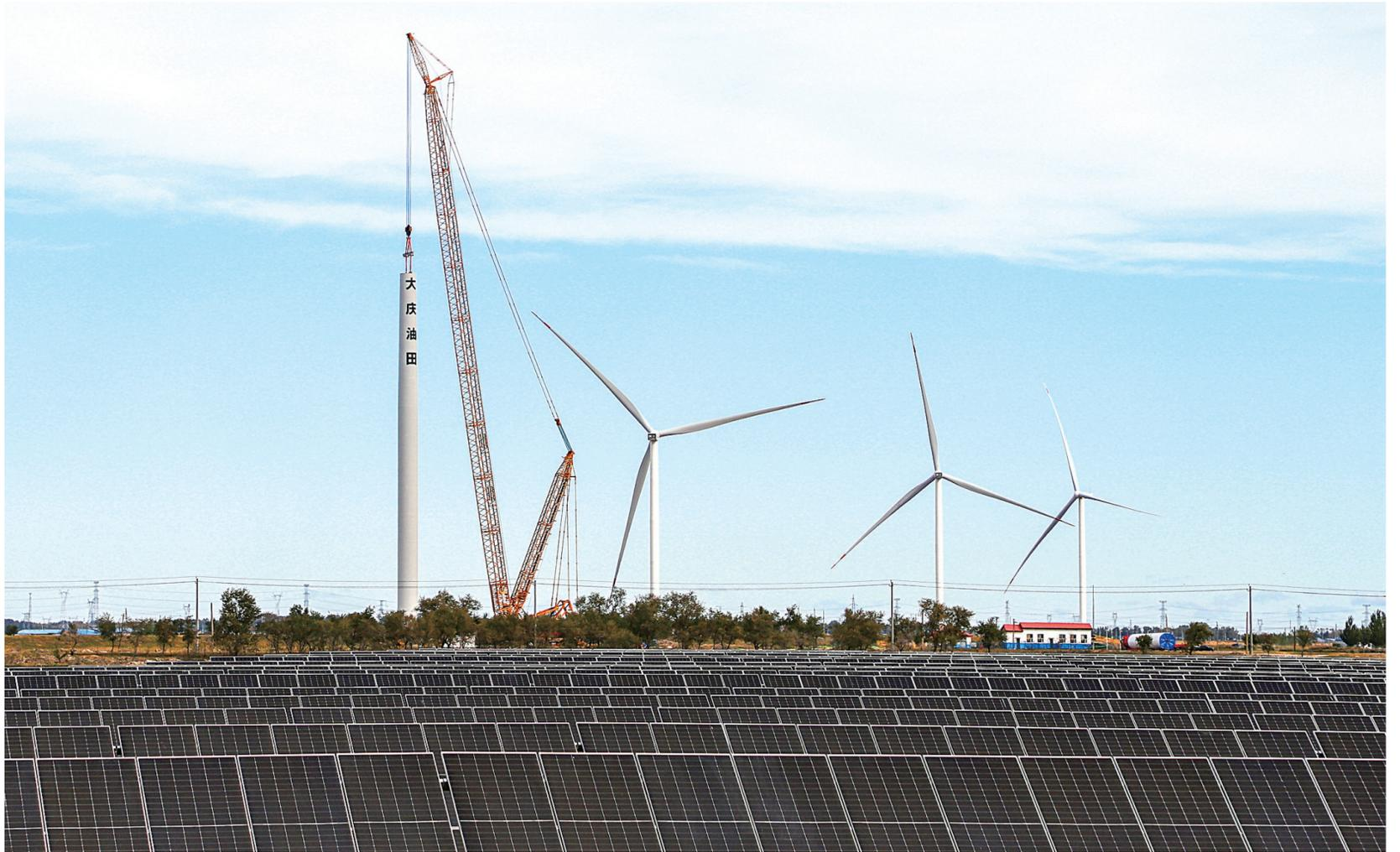
2024年9月20日,在大庆喇嘛甸油田低碳示范区,光伏基地附近在安装风力发电机。
