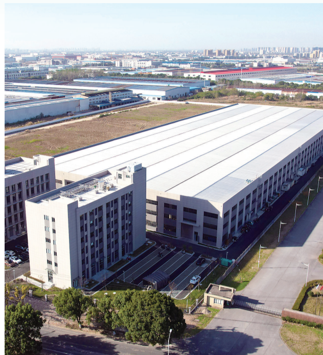
璜土镇“村村富”产业孵化园项目。
