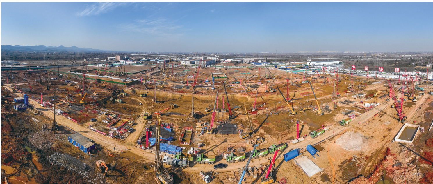
这是2025年2月10日拍摄的南京北站枢纽工程施工现场(无人机照片)。
