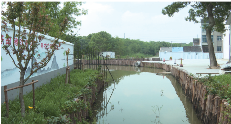
河道面貌焕然一新。
