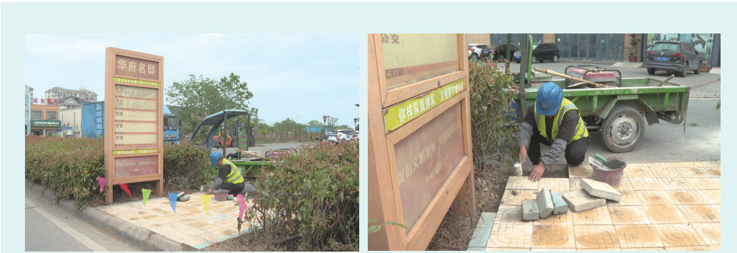
施工人员正在铺设道板砖。
