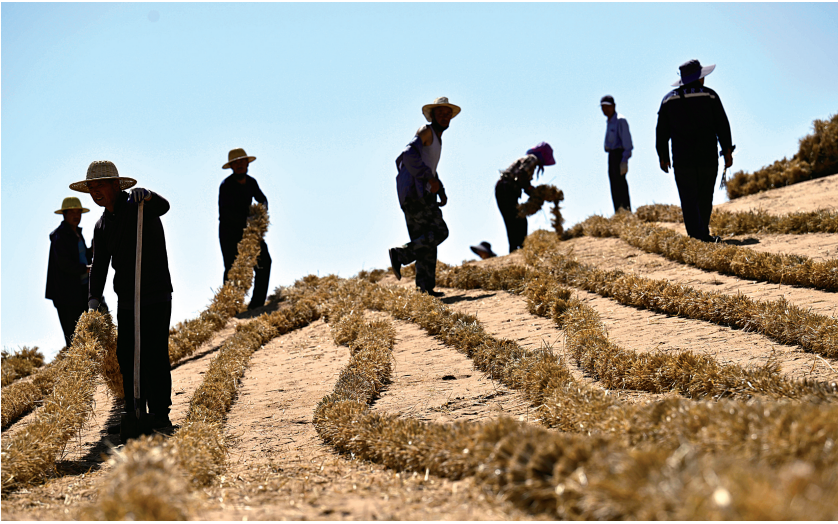
2025年6月30日,治沙工人在位于宁夏中卫市长流水村的腾格里沙漠东南缘扎草方格。
