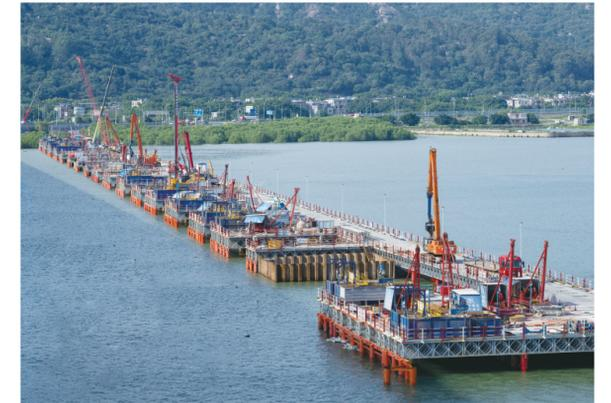
这是漳江湾跨海特大桥主栈桥桩基施工现场(7月16日摄)。7月18日,新建漳汕高铁全线控制性工程漳江湾跨海特大桥主栈桥完工,为后续海上各工作面施工奠定基础。漳汕高铁漳江湾跨海特大桥桥梁全长5.8公里,海域部分桥梁长5公里。目前,大桥主体结构施工正在有序推进。(新华社发)
