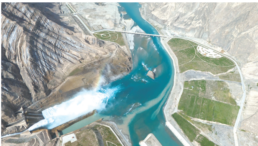
这是8月7日拍摄的阿尔塔什水利枢纽工程(无人机照片)。
