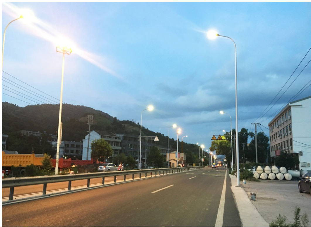
日前,桥墩“亮灯工程”完工,一盏盏小小的路灯不仅照亮了道路,更温暖了人心。该“亮灯工程”,即104国道桥墩段路灯新建项目,全长10.5公里,分两个标段实施。第一标段:104国道线(柳洋村至金山头村)路灯新建工程共设置路灯152盏,工期60天,投资234万元;第二标段:104国道线(桥墩大桥至分水关)路灯新建工程设置路灯281盏,工期90天,投资313万元。(叶长如/摄)
